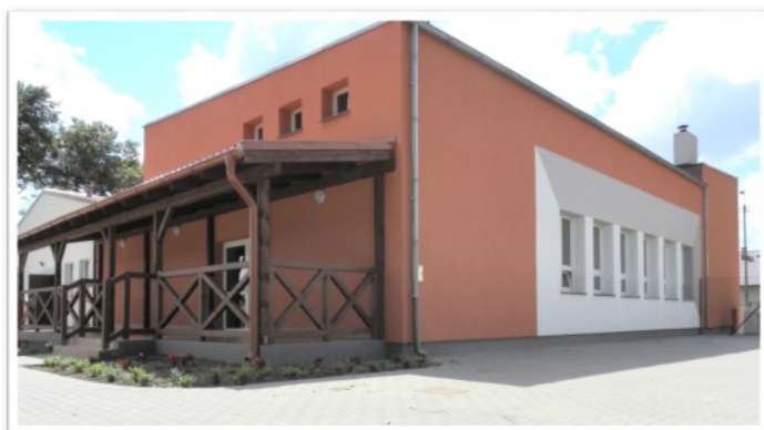
Budynek świetlicy wiejskiej w Kęsowie
