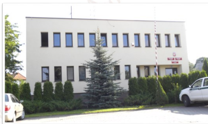
Budynek Urzędu Gminy
