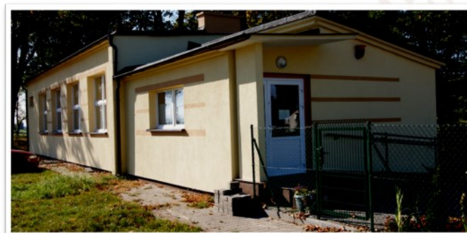
Budynek świetlicy wiejskiej w Żalnie
