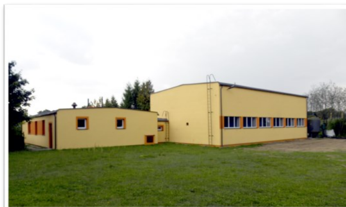
Budynek ZGK po modernizacji w Kęsowie
