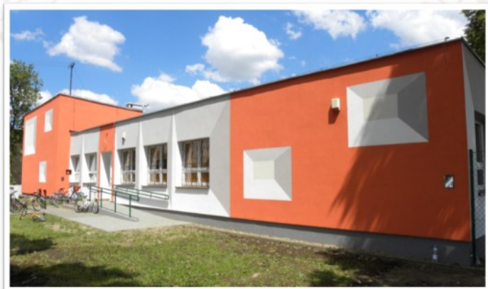
Budynek świetlicy wiejskiej w Kęsowie
